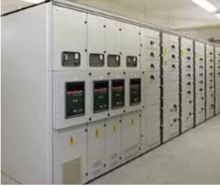
Fig 9 400 VAC MNS Low Voltage Switchgear
